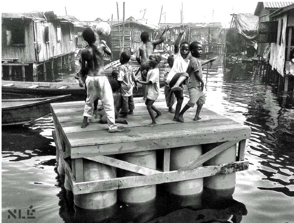
Rysunek 1. Jeden z 16 segmentów platformy, w tle typowa zabudowa Makoko.
